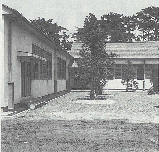
役場庁舎は昭和31年9月に完成。この庁舎は昭和53年まで使用されました。
