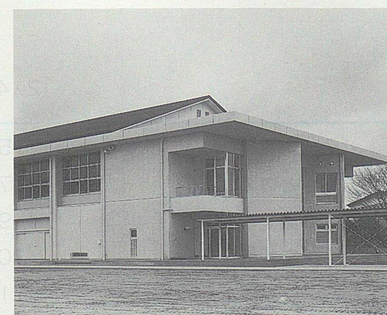
新築された津澄小学校体育館
