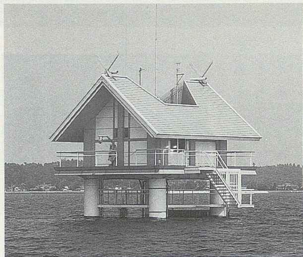
釜谷沖水質監視所
