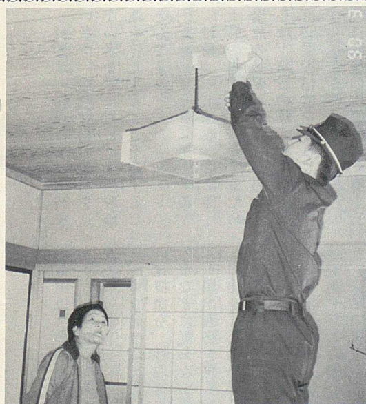
▲消防署員によって天井に取付けられるミニ・アラーム
