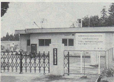
繁昌地区 簡易水道拡張工事
