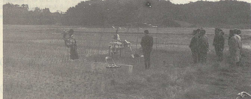
▲ 現地での起工式
