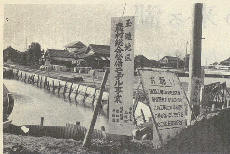
▲看板も立って、工事着工
