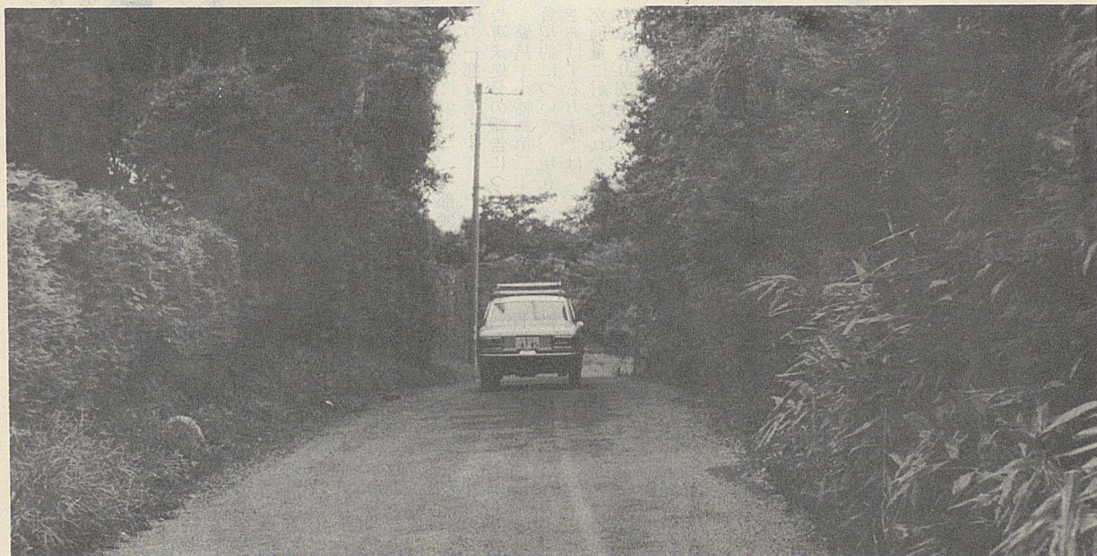
整備が進む村道舗装
