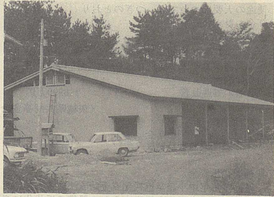
完成まじかいキヤリング倉庫
