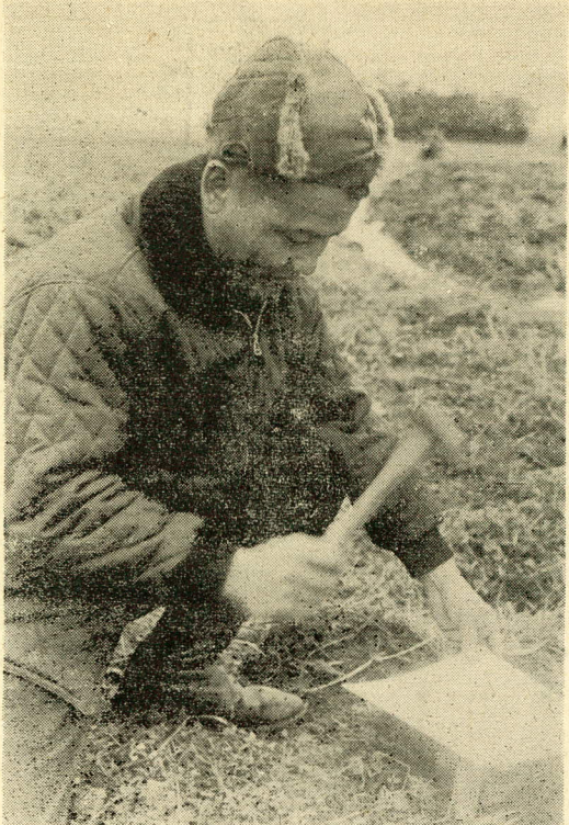
対空標識(空中写真の目じるし)の取付作業
