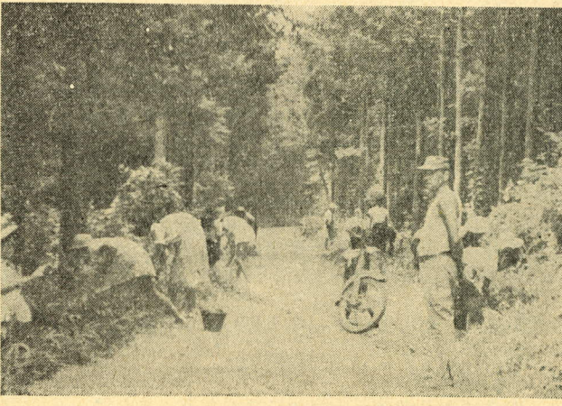
写真はその奉仕作業
