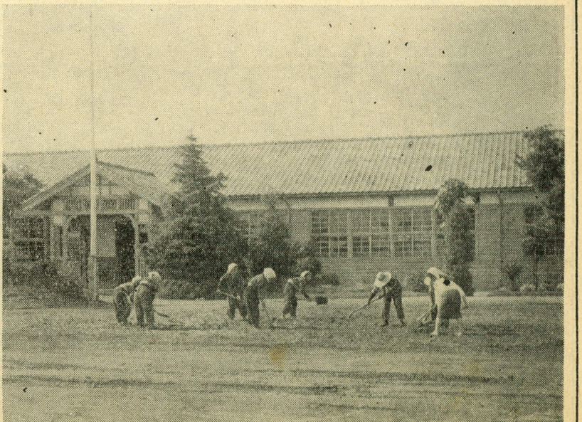
新城小学校PTAの奉仕による校庭砂盛作業
