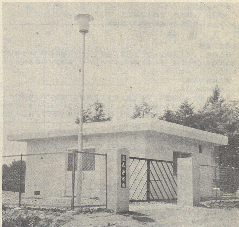
完成した泉浄水場
