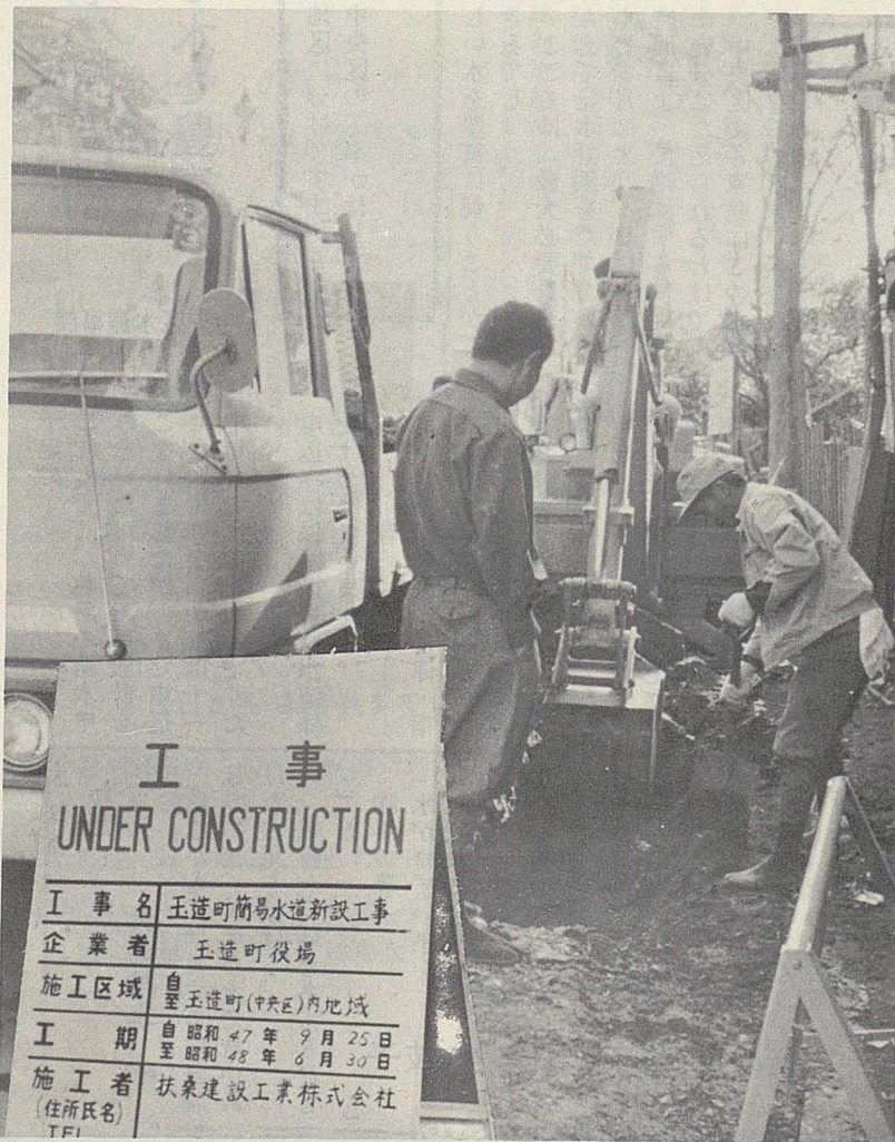
配水管の埋設工事がはじまった柄貝地内
