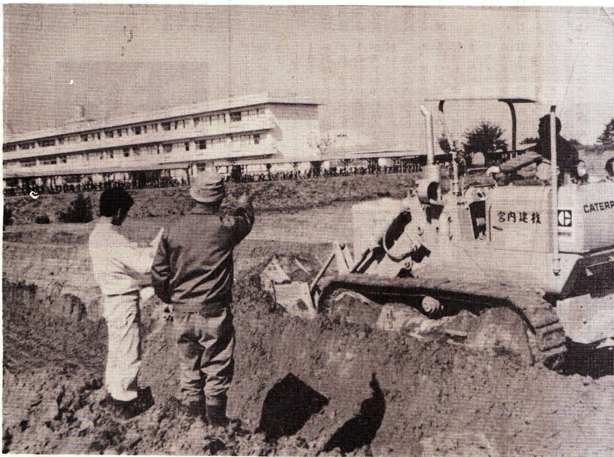
整地作業 轟音とともに、土くれがほぐされ、こんどは基礎工事が……
