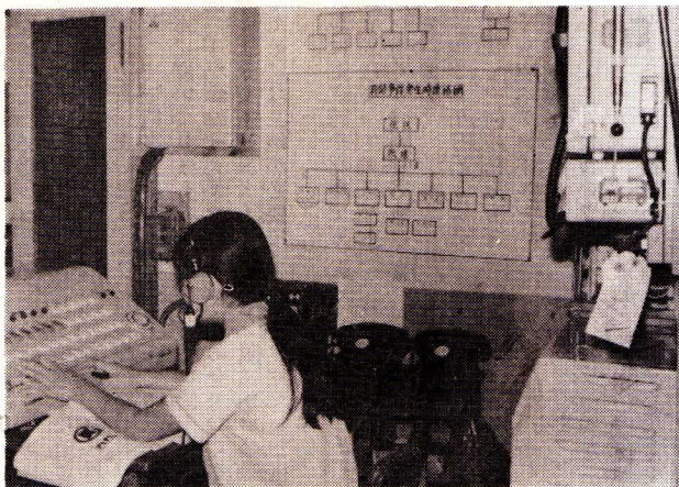
役場交換台には、羽生、玉造、井上からの119番のほか、無線電話機が備わっている
