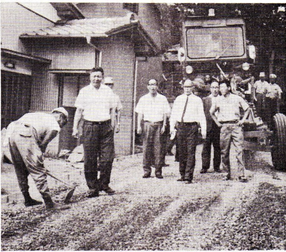
町道舗装工事現場視察の一行
