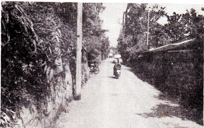
▲町道186号線舗装 新宿地内 延長 320 m 工費 119万円
