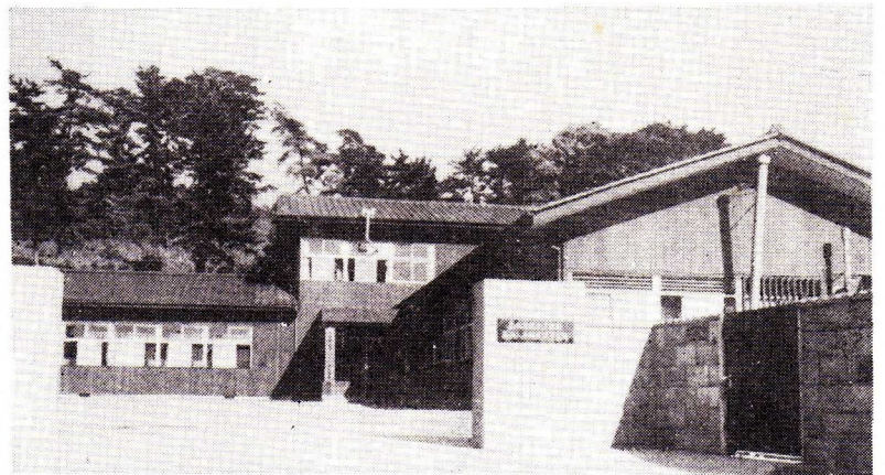
▲農林省高浜入干拓建設事務所 浜地内 敷地 5200㎡ 工費 1162万円
