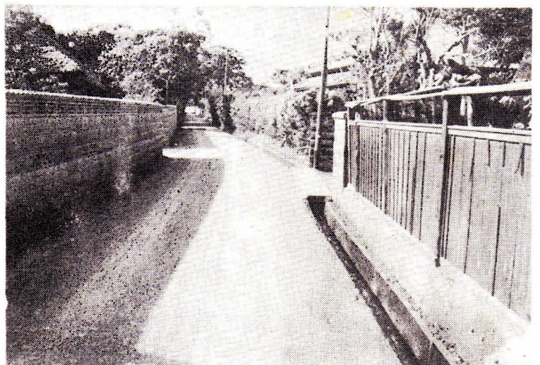
▲県道舗装 八木蒔、浜、藤井地内 (写真は八木蒔地内)
