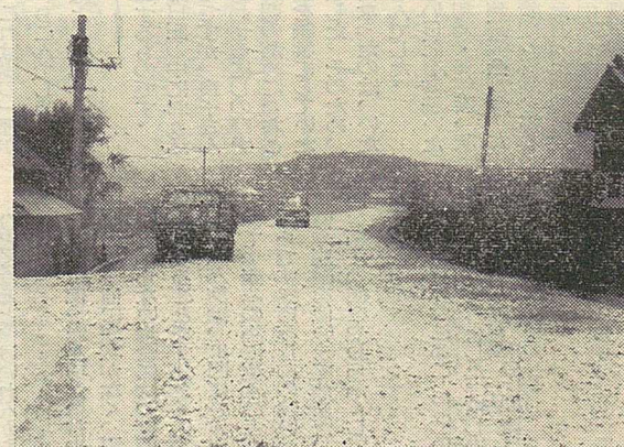
⑦県道銚田小川線簡易舗装工事 大字井沢、(上山)地内 延長 200㍎ 工費 160万円 施工 県直営 昭和39年3月完成
