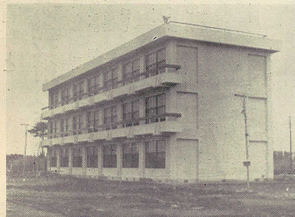
3、玉造工業高等学校建築工事(県営) 大字中山地内 工費3900万円 施工宇野建設 昭和38年3月完成
